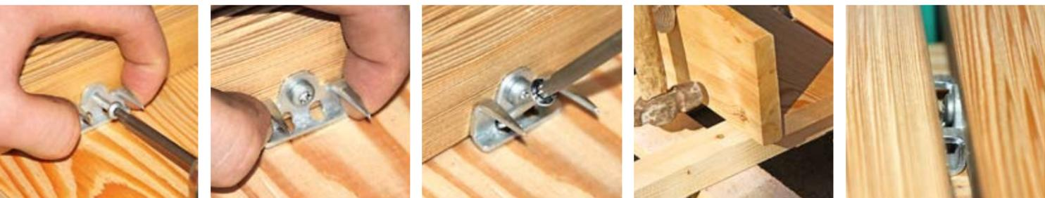
**1** Устанавливаем первую доску на основание и крепим ее край саморезами требуемого размера. Для обеспечения плотного прилегания доски к основанию рекомендуется использовать саморезы с неполной резьбой. Устанавливаем крепеж.
