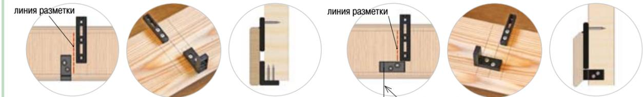
**4 Монтаж рядовых досок к обрешетке.** Устанавливаем сборку А-спейсеров, зацепив ее за монтажный шнур, временно установленный в зоне обрешетки. Устанавливаем рядовую доску с крепежом ДУЭТ-фасад, через монтажные отверстия крепежа саморезами №2 фиксируем ее к обрешетке. Крепим необходимое количество планкена. А-спейсеры перемещаем только после крепления 3-4-х рядов. Свободный край последней доски фиксируем наиболее удобным способом.
